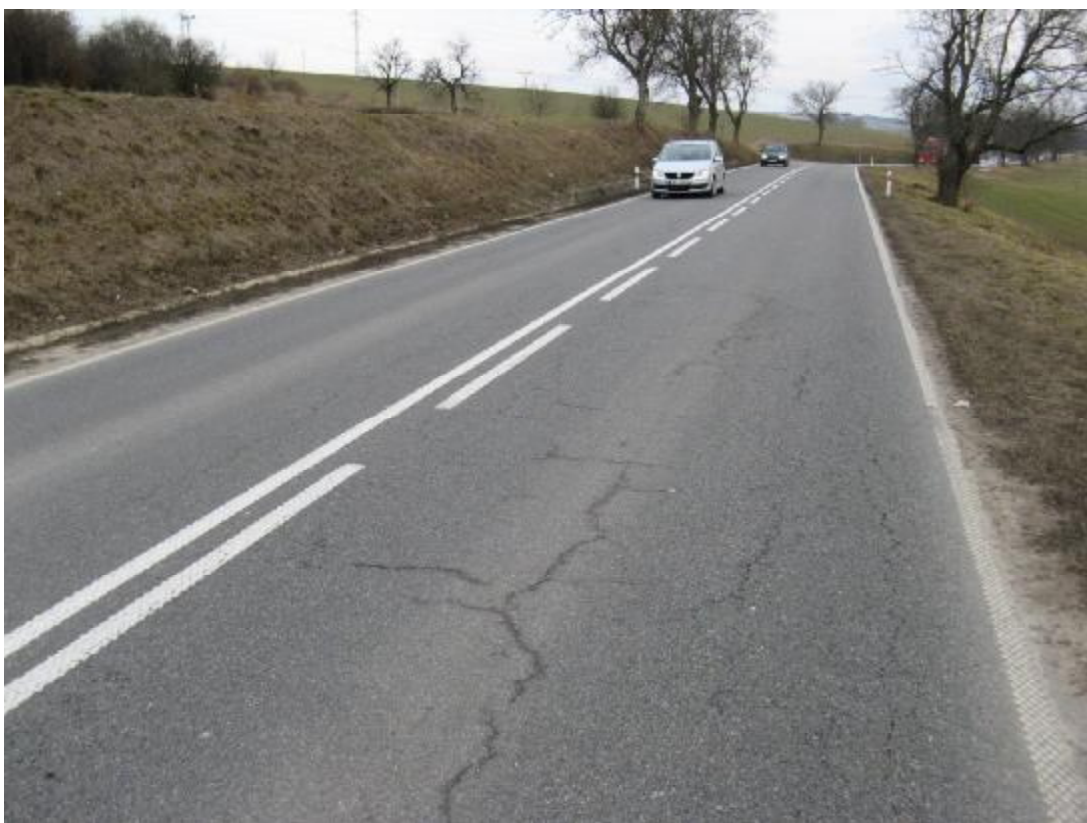
F29, km 1,140- Podélné rozvětvené a mozaikové trhliny.
