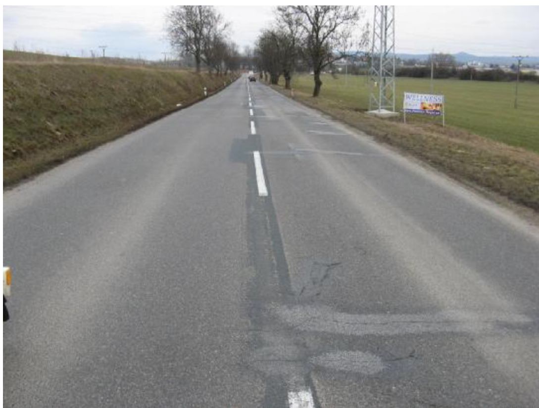
F20, km 1,000- Příčné a nepravidelné nebo mozaikové trhliny.
