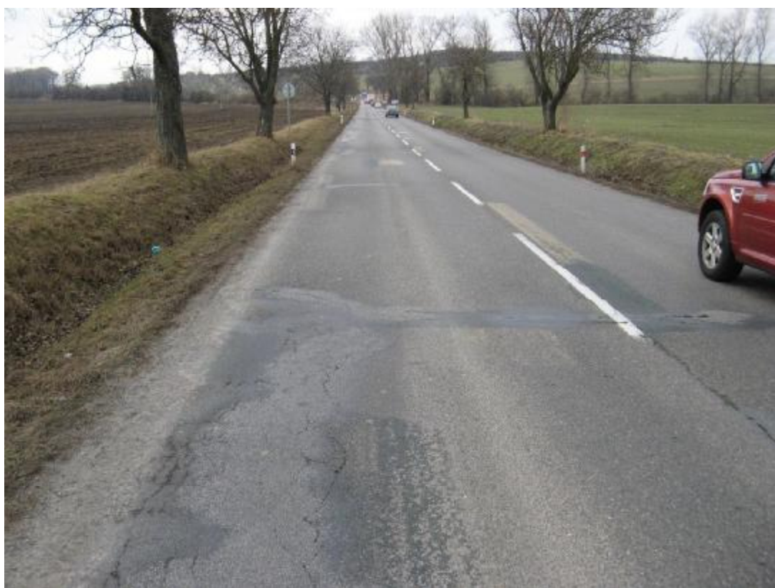
F04, km 0,090+ Lokální síťové trhliny, příčná trhlina rozvětvená.
