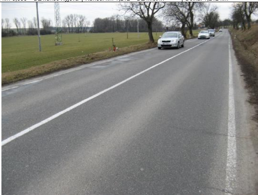
F16, km 0,710+ Vlevo lokální síťové trhliny, vpravo začínající příčné trhliny.
